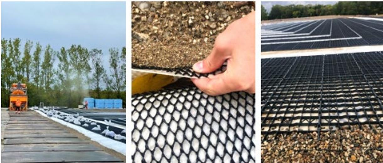
*Baustelle Erdbeckenspeicher Taastrup (Aufbringen der Ballastierung/ Textil zwischen Isolation und Schüttung/ Noch nicht ballastierter Beckenbereich), Fotos: H. Erhardt, J. Meng*
