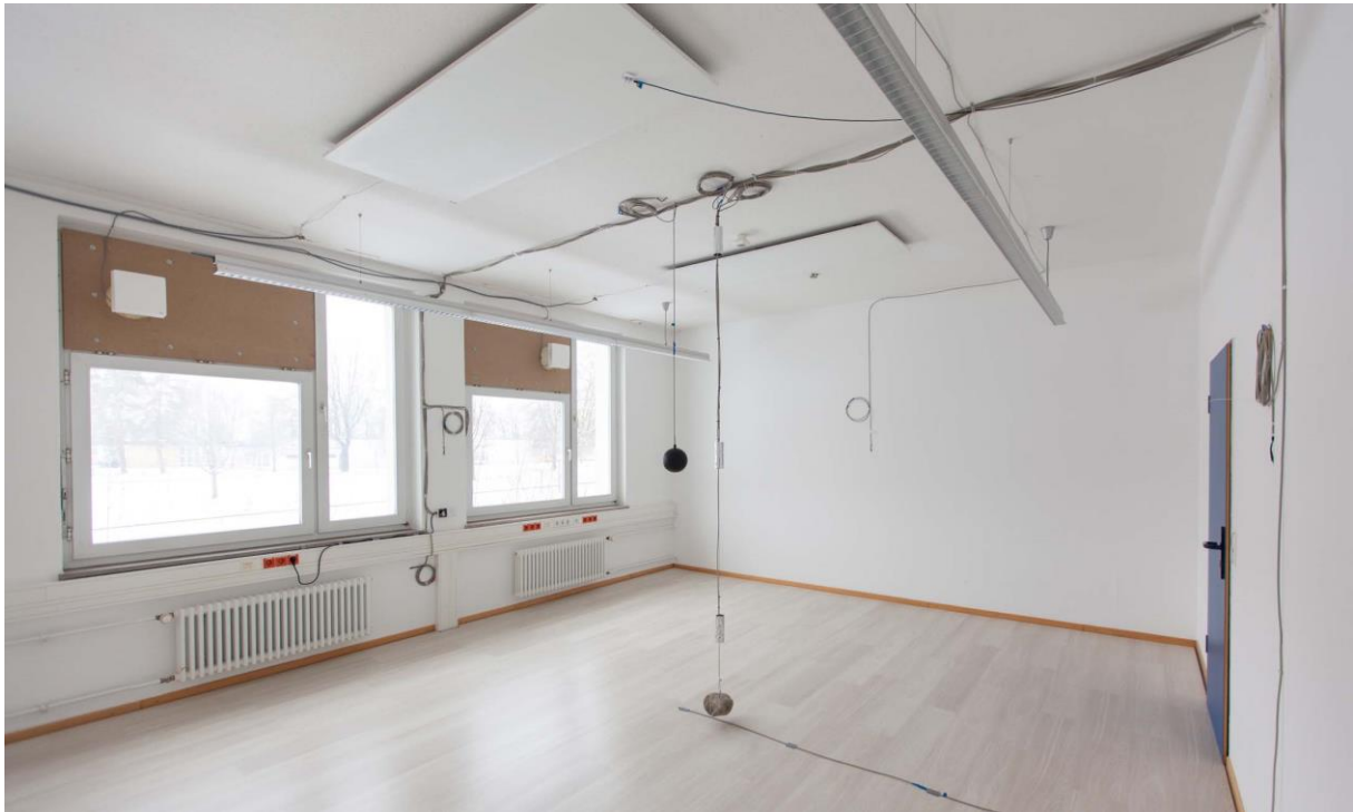
Abb. 45 Laborraum T3 mit IR-Heizung an der Decke
