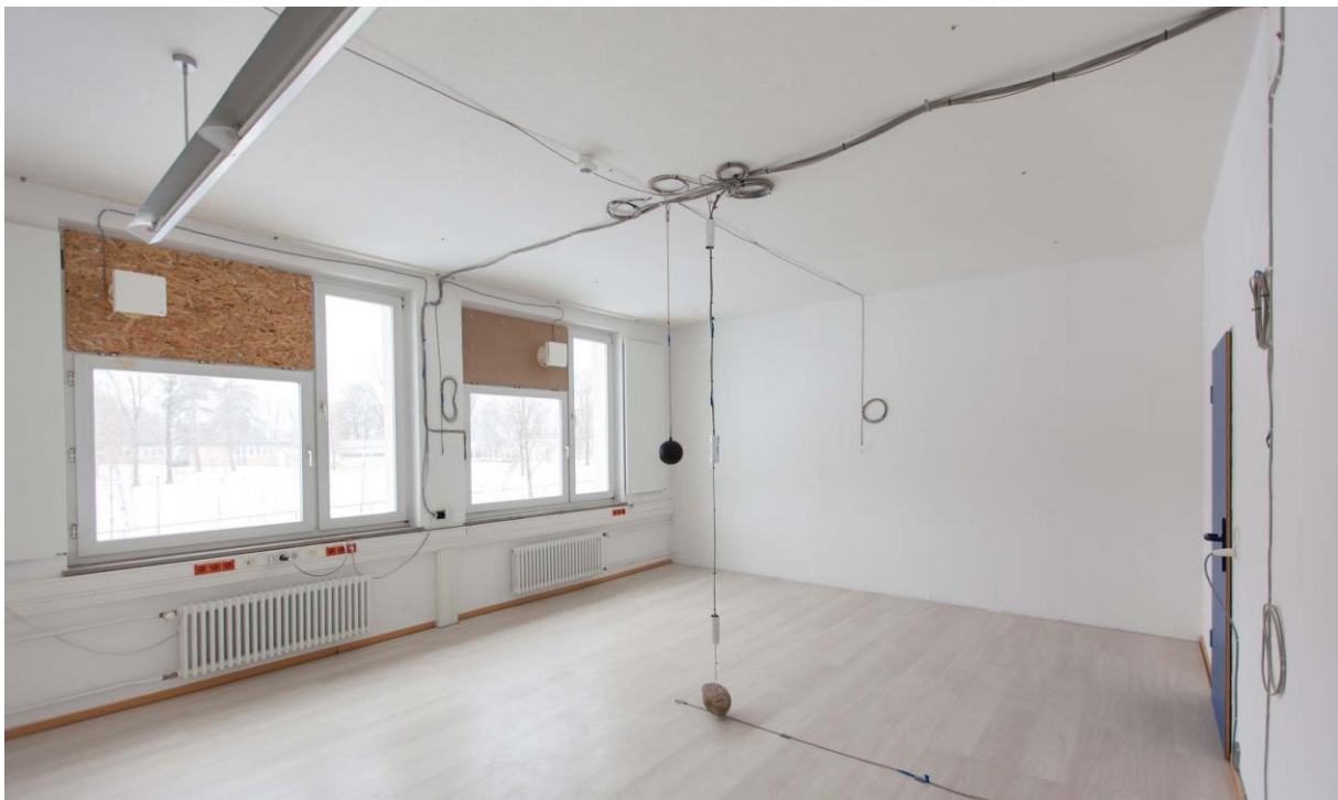
Abb. 46 Laborraum T4 mit IR-Heizung an der Wand
