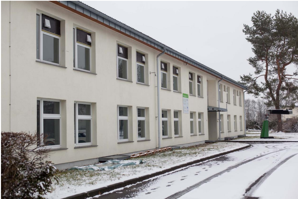
Abb. 47 Südfassade Gebäude 6 mit Einzellüftern
