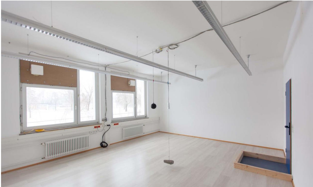
Abb. 44 Laborraum T2 mit elektrischer Fußbodenheizung
